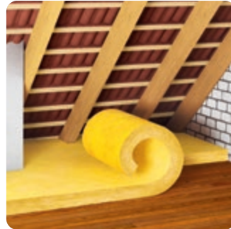
Oberste Geschossdecke, nicht begehbar
