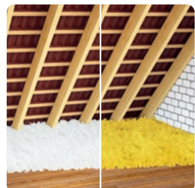
Oberste Geschossdecke, begehbar / nicht begehbar
